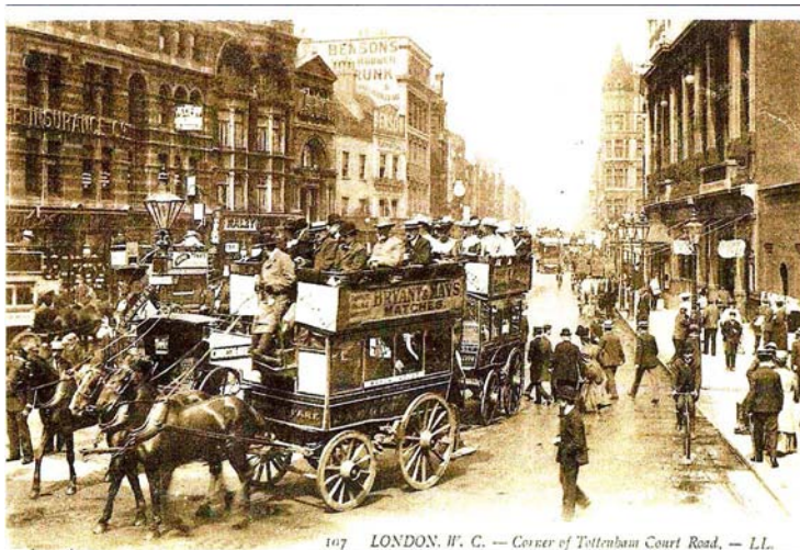
Fig. 4 : À l'impériale de l'omnibus, les passagers sont aux premières loges pour voir la ville.
